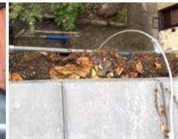
Komoly problémákhoz vezető hibák: a cseppentőlemez hiánya, illetve az elmaradt karbantartás
