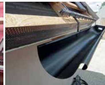
Külső peremes ereszcatorna szerelés közben
