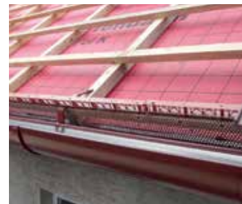
A szükséges eresztartozékok helyes beépítése
