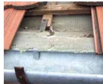
Komoly problémákhoz vezető hibák: a cseppentőlemez hiánya, illetve az elmaradt karbantartás
